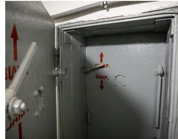
Тамбур-шлюз з захисно-герметичними дверима
